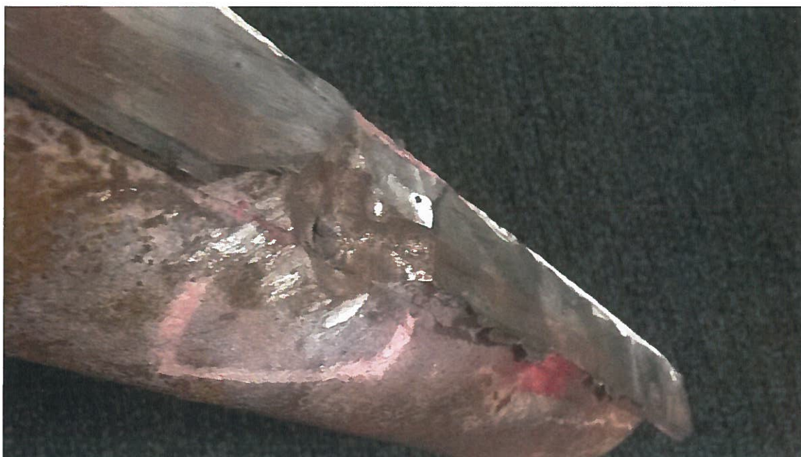
Figuur 3 Lekkage I met impactschade rond het gaatje
